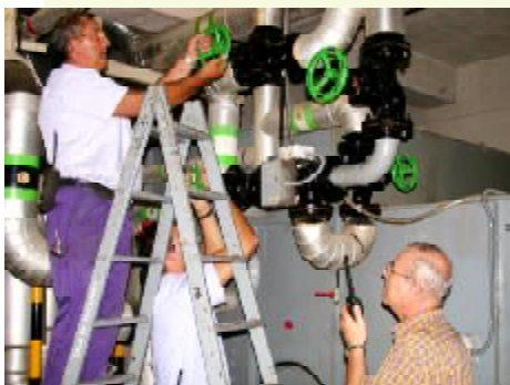
Equip de Manteniment a la Sala de Màquines. S.R.
