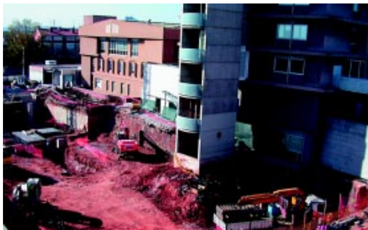
Inici de les obres de fonamentació de l'edifici Taulí nou . S.G.
