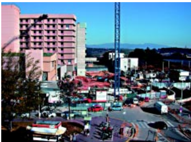
Les obres han obligat a restringir el trànsit al recinte Taulí. S.G.
