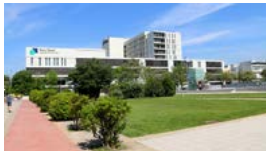
Façana de l'edifici Taulí.
